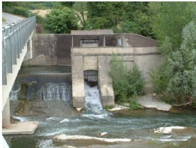
Central hidroelèctrica a Montesquiú
