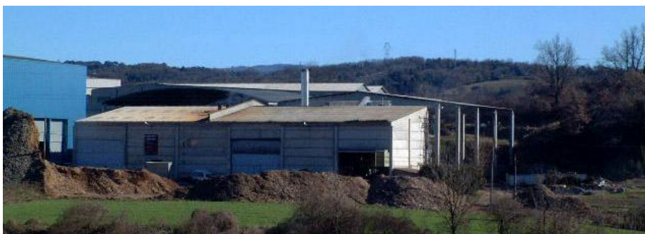
Figura 12.1.2 Central Tèrmica de Sant Pere de Torelló
